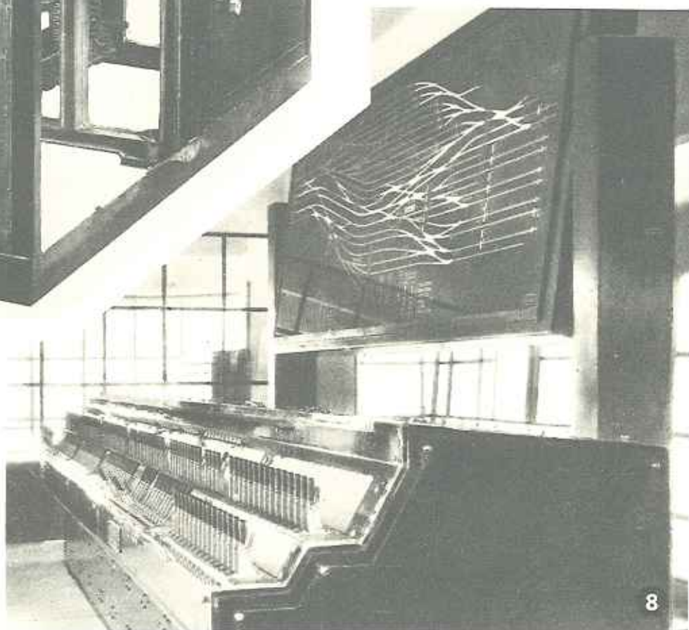
8. Interno della cabina di manovre di un apparato centrale elettrico (Roma-Termini, cabina A1). Come si vede chiaramente, le leve del banco, dato il loro grande numero, sono disposte in due file. Per la manovra dei grandi banchi come questo non basta un solo deviatore, ma ne possono occorrere anche tre o quattro. Al disopra del banco è sostenuto il quadro luminoso a trasparente, sul quale è riprodotta la zona di piazzale comandata dall'apparato: l'accensione di apposite lampadine indica ai deviatori in quale posizione si trovino i segnali, e quali tratti dei binari principali siano liberi od occupati da veicoli. 9. Interno della cabina di manovre di un grande apparato centrale elettrico (Firenze - S. M. N.). Anche in questa figura si vede il banco a doppio ordine di leve ed il quadro luminoso.
